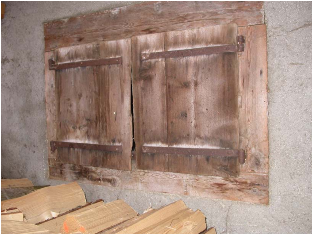
Deux volets avec encadrement original en bois.
